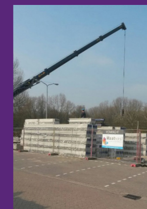
De eerste foto van de bouw dorps huis Badhoevedorp, gemaakt door Maarten en Peter op de bouwplaats
